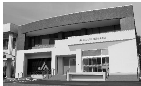
令和5年3月 揖斐中央支店オープン
